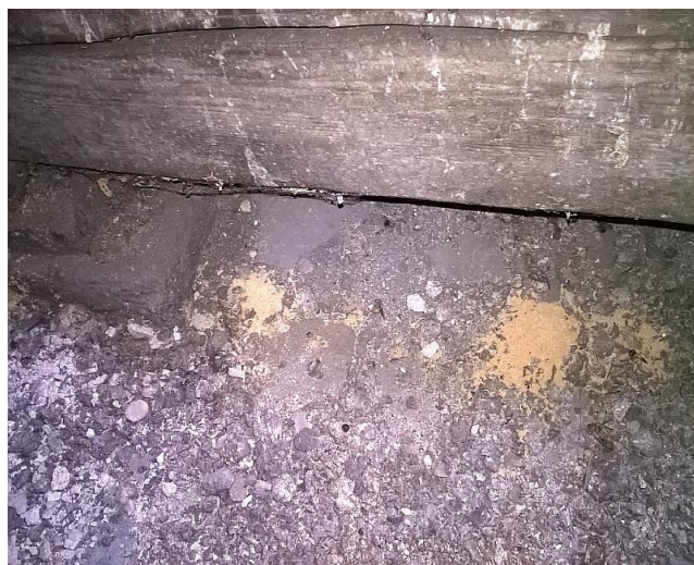
Jezdecká kasárna 2.9.2015, stopy po vodě, přístavku, dřevokazném hmyzu a průzkumu motorovou pilou.
