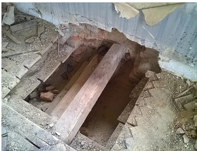
Jezdecká kasárna 2.9.2015, stopy po vodě, přístavku, dřevokazném hmyzu a průzkumu motorovou pilou.
